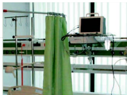
Bară eurorail (25 x 10 mm) superioară pentru accesorii: lămpi examinare, sisteme separatoare de perdele, etc. (opțional: bară eurorail 35 x 10 mm)
